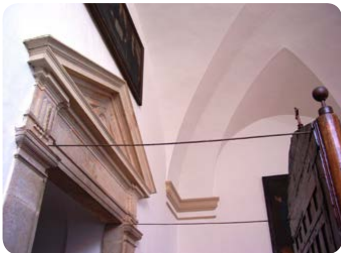
Detalle del cancel y de la puerta de acceso en el alzado interior hacia el oeste
